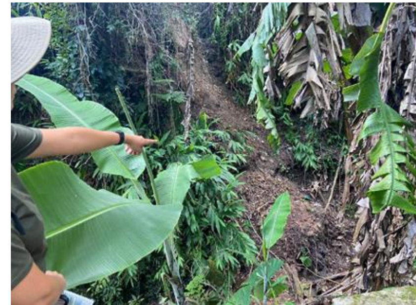
Deslizamento próximo à ponte de ferro
