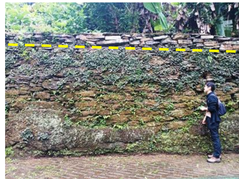
Muro histórico com camada de intervenção recente
