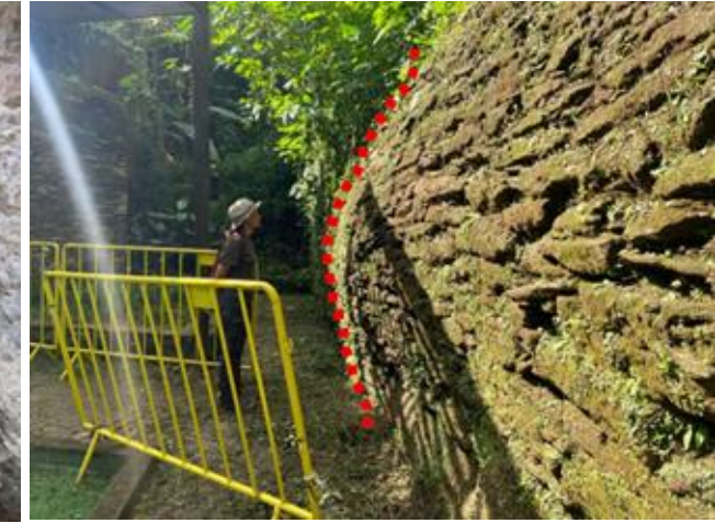
Muro côncavo (entrada Pilar)
