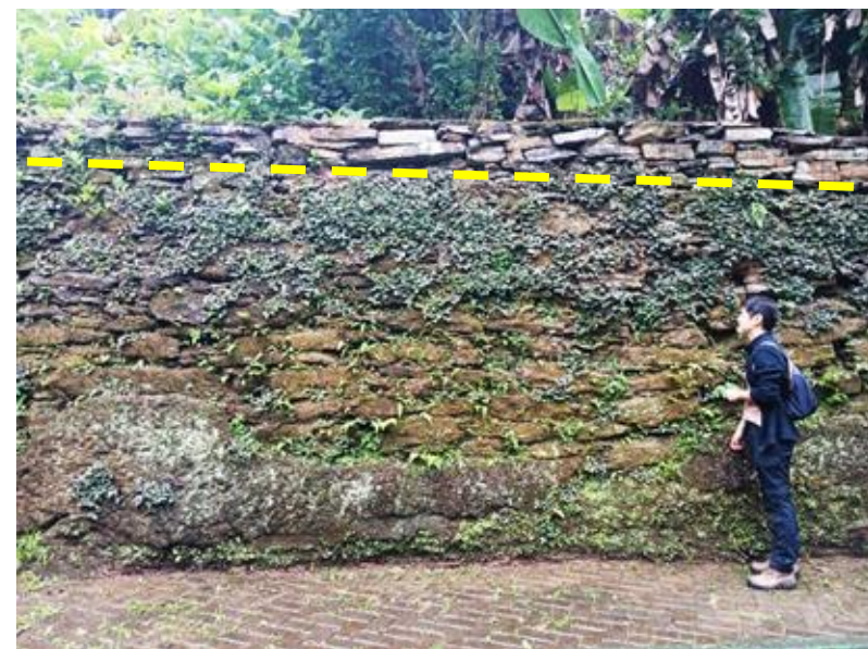
Muro histórico com camada de intervenção recente
