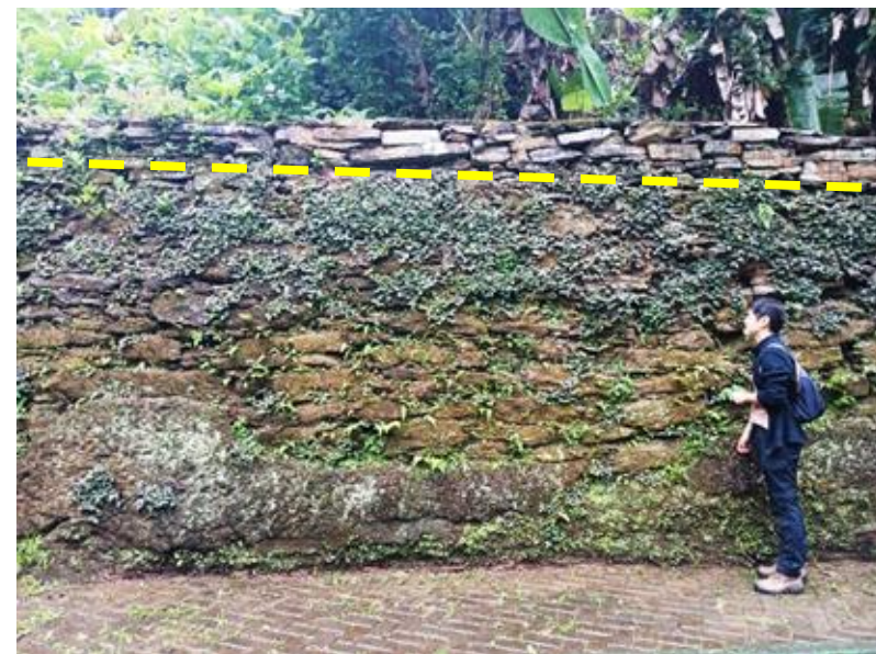
Muro histórico com camada de intervenção recente
