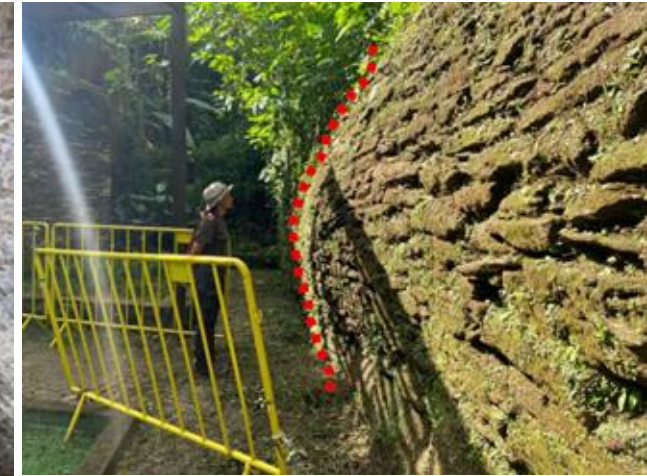
Muro côncavo (entrada Pilar)
