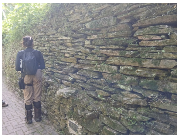
Figura 5-18 Detalhe do muro
