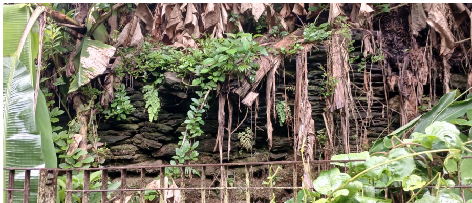
Figura 5-32 Detalhe da estrutura de pedra 05
