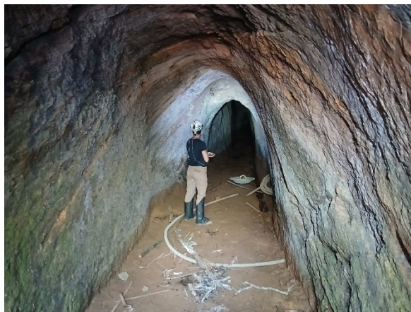
Figura 5-34 Interior da Antiga Mina 01. Observa-se a presença de lixo no entorno.
