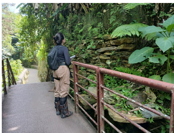
Figura 5-16 Localização dos muros – próximo à ponte de ferro.
