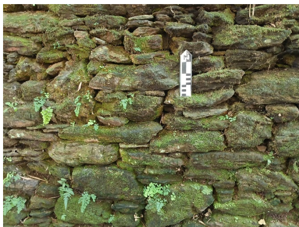
Figura 5-17 Detalhe da técnica construtiva de pedra seca
