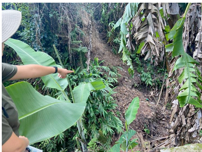
Figura 6-37 Detalhe do deslizamento com presença de bananeiras no entorno.
