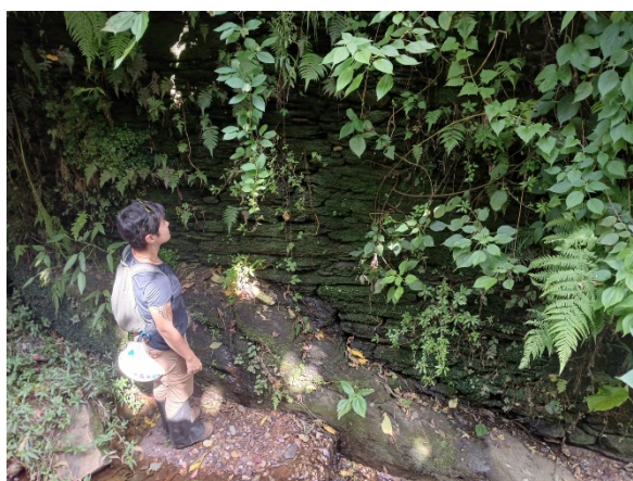
Figura 5-19 Muro histórico que faz contenção na outra margem do trecho.
