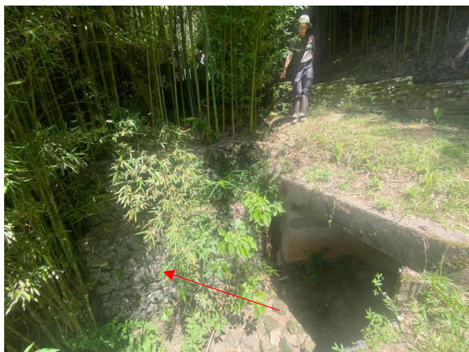
Figura 6-6 seta aponta para o muro de gabião.
