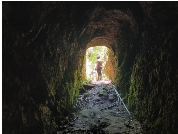
Figura 3-34 Vista de dentro para fora da mina
