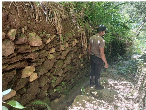
Figura 3-4 Parte do Muro Histórico à direita
