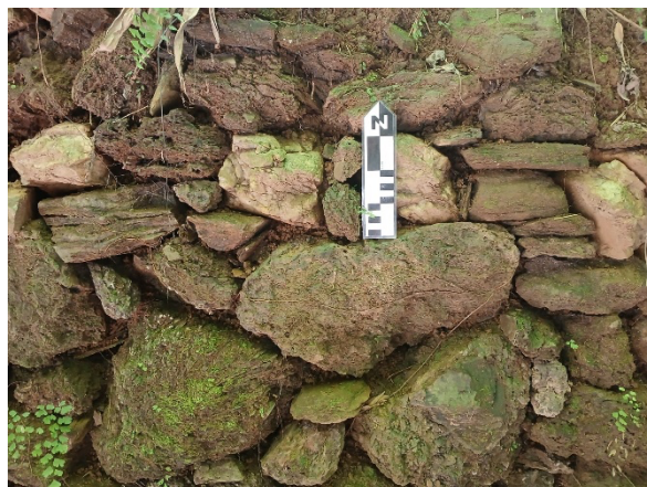
Figura 3-7 Detalhe da técnica construtiva em pedra seca
