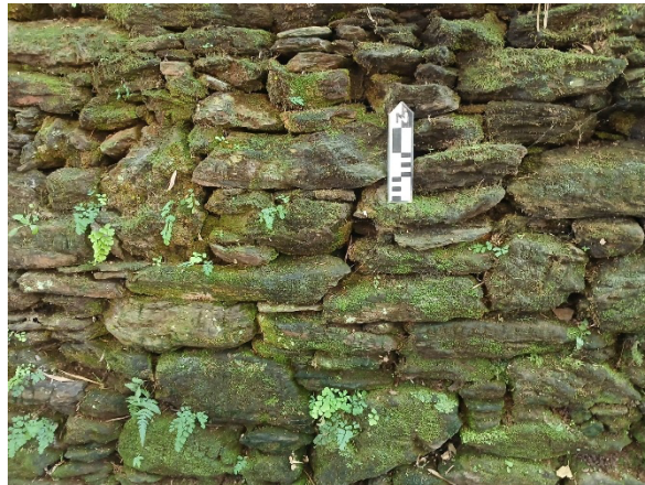
Figura 3-15 Detalhe da técnica construtiva de pedra seca
