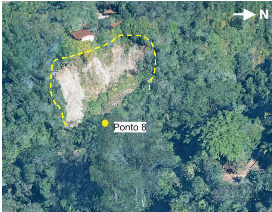
Figura 5-24 linha tracejada destaca o antigo deslizamento próximo do ponto.
