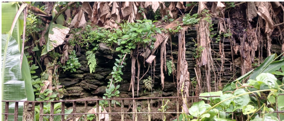
Figura 3-30 Detalhe da estrutura de pedra 05
