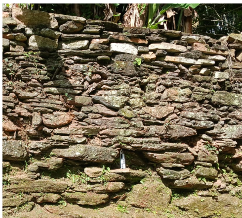
Figura 3-26 Detalhe da diferença de camadas, sendo a do topo mais recente.
