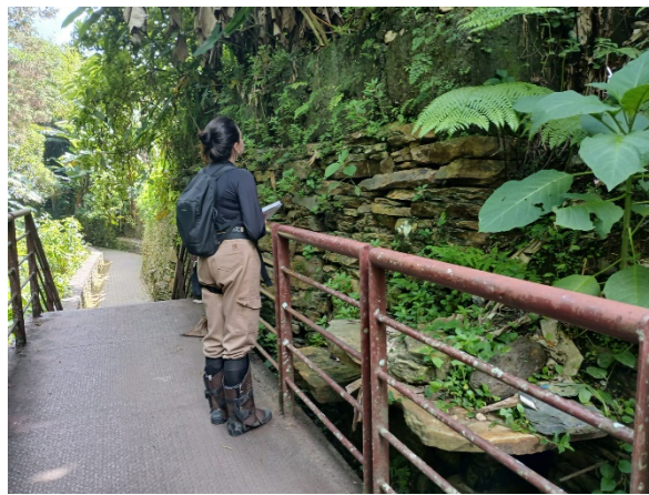
Figura 3-14 Localização dos muros – próximo à ponte de ferro.
