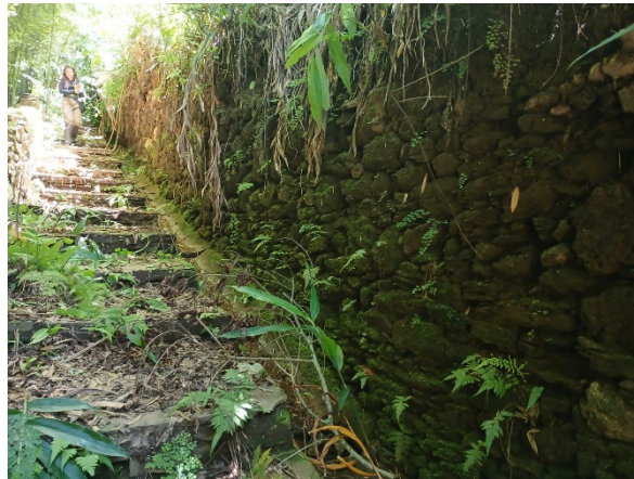
Figura 3-6 Vista do Muro Histórico coberto pela vegetação
