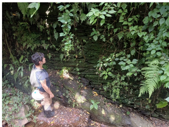
Figura 3-17 Muro histórico que faz contenção na outra margem do trecho.
