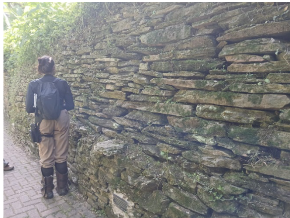
Figura 3-16 Detalhe do muro
